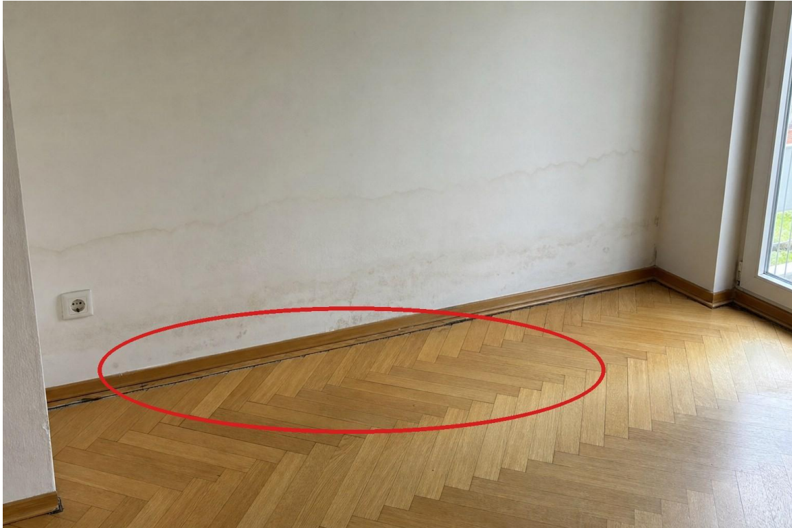
Bild 10 — Feuchtehorizont Top 11
