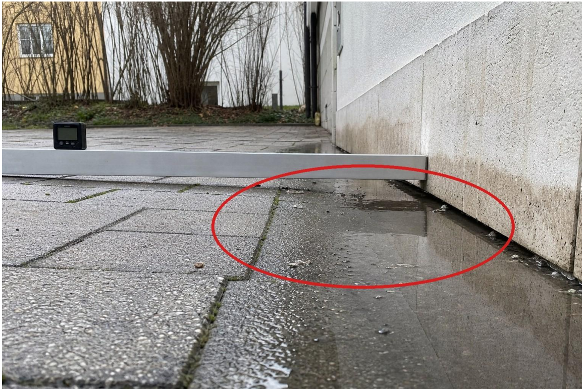
Hofbelag mit Gefälle zum Gebäude
