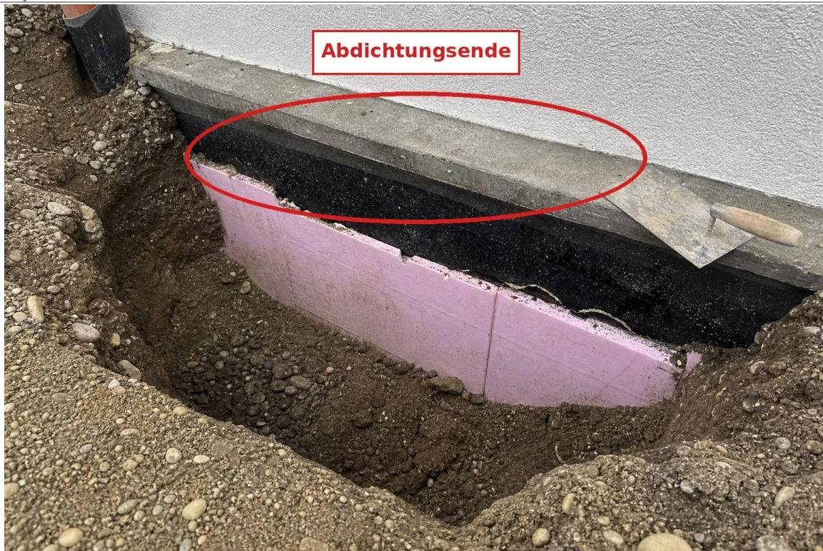
Bild 2 — Sondierung S1 — Abdichtungsende
