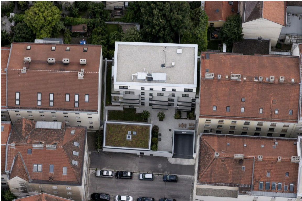
Bild 12 — Luftbild der Liegenschaft
